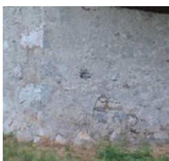
Prieuré de Meillerie et détail d'enduit et de décor de faux appareil au badigeon de chaux (en plus clair, imitant la teinte naturelle de la pierre calcaire).
