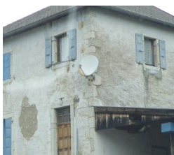
Maison des Sœurs, Chevenoz L'enduit fouetté est recouvert d'un badigeon de chaux.
