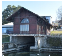
Chalet-garage à bateau de la Sapinière, Évian.
