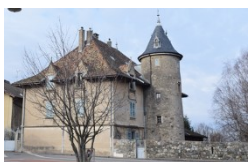
Maison forte de Neuvecelle : son enduit de la teinte du sable a été lessivé par la pluie, il est devenu « à pierre vue ».
