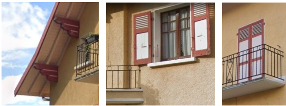
Coyau sur avant-toit, sous face lames et chevrons apparents, bicolore, comme les pannes triplées à ressaut.
