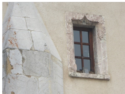
Abondance, abbaye monument historique : enduit de chaux de restauration avec un encadrement net autour des baies en pierre de taille moulurées et linteau en accolade
