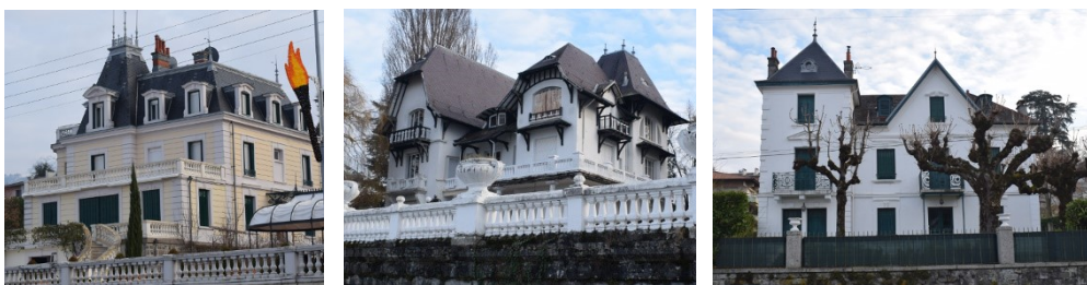
Villas de plus de quatre travées souvent couvertes de toitures composées de plusieurs volumes.
