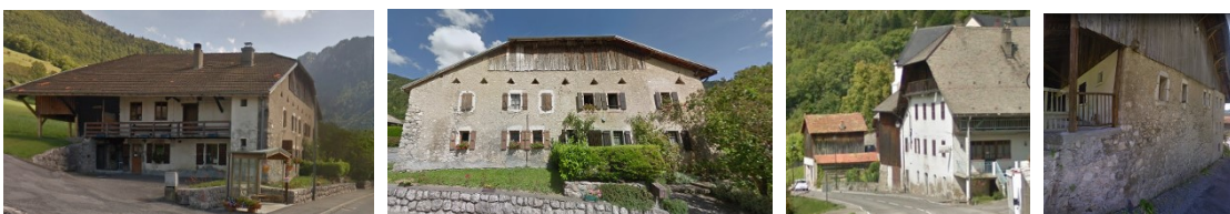
Vacheresse : pignons lisses en maçonnerie, aux ouvertures régulières, couronnés d'un bardage vertical protégé par la demi-croupe
