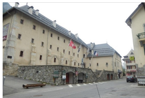
Abondance, abbaye monument historique : enduit de chaux de restauration avec un encadrement net autour des baies en pierre de taille moulurées et linteau en accolade
