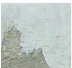
Maison forte de Neuvecelle : son enduit de la teinte du sable a été lessivé par la pluie, il est devenu « à pierre vue ».
