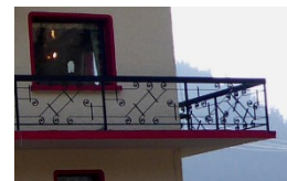
Balcon béton avec serrurerie Art Déco à Châtel.
