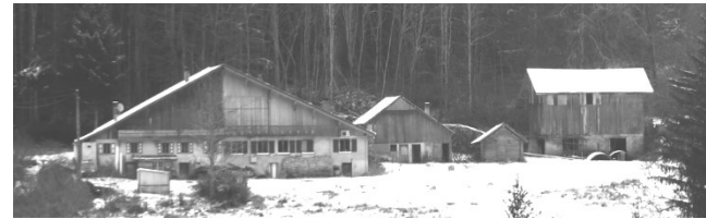
Abondance : les annexes apportent un « contrepoint » au volume imposant de la ferme double.
