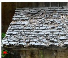
Tavaillons en bois d'épicéa qui vieillit gris argent (remise au Fion, Chevenoz)
