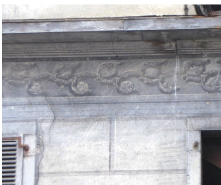
Évian, décor de grisaille au badigeon de chaux sur enduit : faux appareil et frise à décor floral en grisaille sous le fronton (immeuble prévu détruit pour la réalisation de logements neufs).
