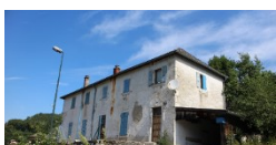
Maison forte de Neuvecelle : son enduit de la teinte du sable a été lessivé par la pluie, il est devenu « à pierre vue ».
